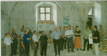
Technischer Amtsrat Johann Schütz (Zweiter von rechts) erklärte als Mitarbeiter des Hochbauamtes der CSU-Kreistagsfraktion die anstehenden Sicherungs- und Sanierungsmaßnahmen in der Friedrichsburg. Bild: mor
